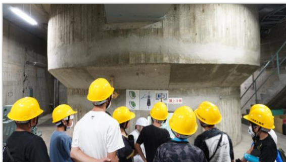
柚ノ木発電所の地下施設見学
