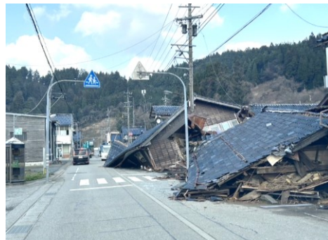
輪島市：倒壊家屋
