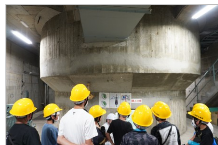
柚ノ木発電所の地下施設を見学
