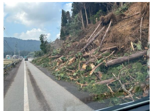
輪島市：斜面崩落し土砂が道路を覆う
