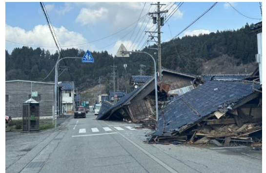
輪島市：倒壊家屋
