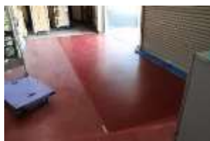
入口床面修繕
