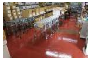
床全面のクリーニング
